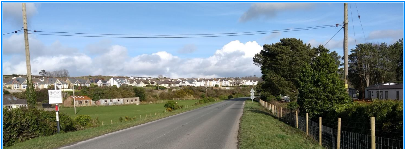
Haul Road from Par Docks to Fowey
