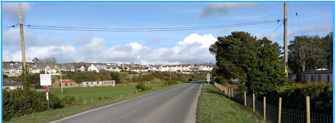
Haul Road from Par Docks to Fowey
